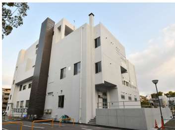
「長崎大学放射線災害対応センター改修工事」 （長崎大学）令和3年3月竣工
