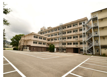
「長崎大学（文教町2）総合研究棟（旧工学部2号館） 改修工事」 （長崎大学）令和2年7月竣工
