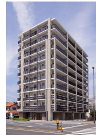
「（仮称）ネオ・プレイス大村西本町新築工事」 （長崎大建不動産㈱）令和2年6月竣工
