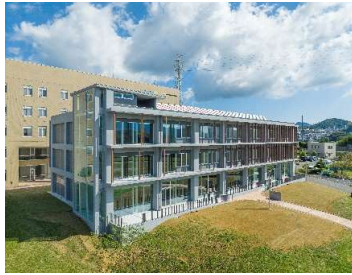
「長崎県立大学シビック校 情報メディア・産学 共同研究センター（仮称）新築工事」 （長崎県立大学）令和4年10月竣工
