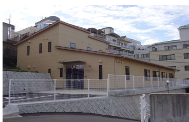
「（仮称）小規模多機能型居宅介護のプラト愛宕Ⅲ新築工事」 （医療法人 博和会）平成30年12月竣工
