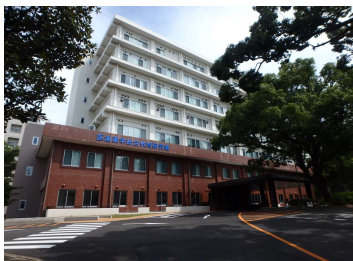
「長崎大学（坂本2）総合研究棟（旧歯学部本館） Ⅲ期改修工事」 （長崎大学）令和2年9月竣工
