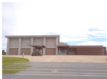
「（仮称）長崎恐竜博物館建設主体工事」 （長崎市）令和3年3月竣工
