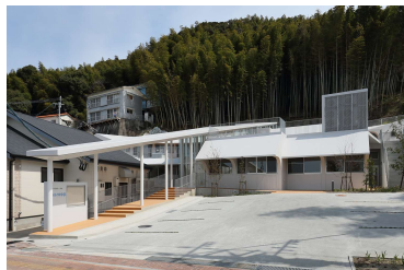
「愛宕保育園新築工事」 （（社福）正道会）平成28年5月竣工
