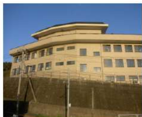
「O邸改修工事」 (長崎市) 平成19年12月竣工
